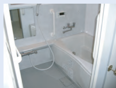
ユニットバス設置
