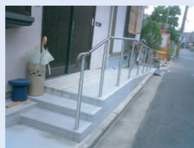
スロープ・階段・手すり等増築
