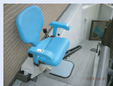
階段昇降機設置
