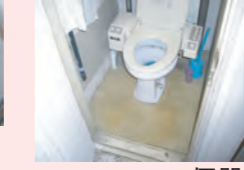
便器かさ上げ
