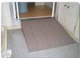
室内に設置した車いす用のスロープ
