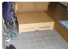
玄関に設置した踏み台式のスロープ (必要に応じて踏み台の中に格納されたスロープを引き出せます)
