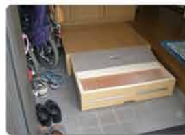
玄関に設置した踏み台式のスロープ (必要に応じて踏み台の中に格納されたスロープを引き出せます)
