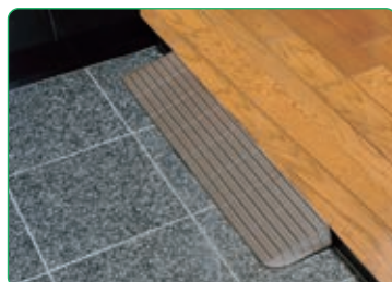
玄関(あがりかまち)の段差
